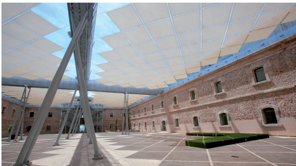
Patio interior edificio CIM.
